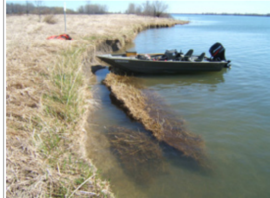
Station de Verchères montrant les structures effondrées au printemps.
